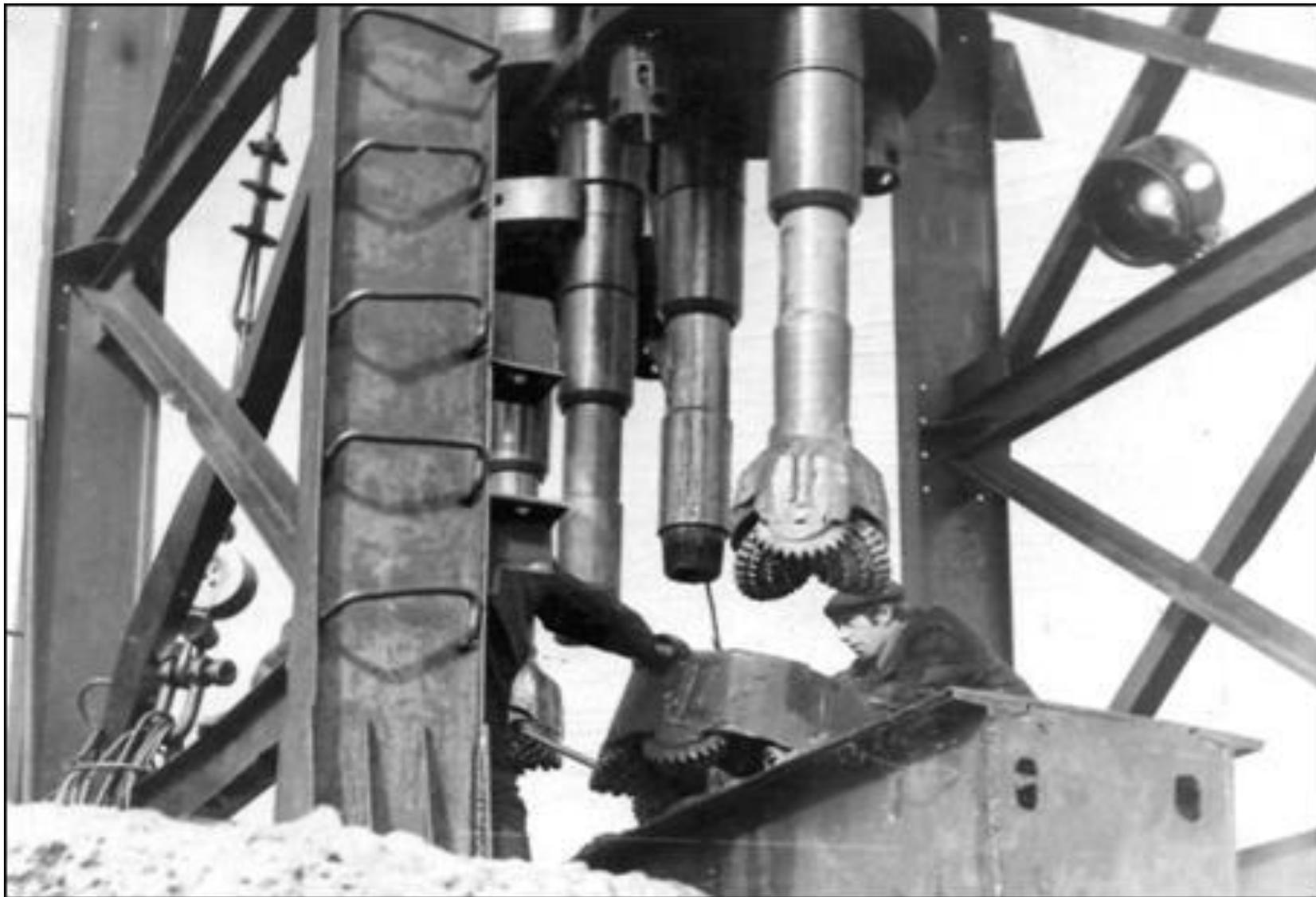
Агрегат турбинно-реактивного бурения
