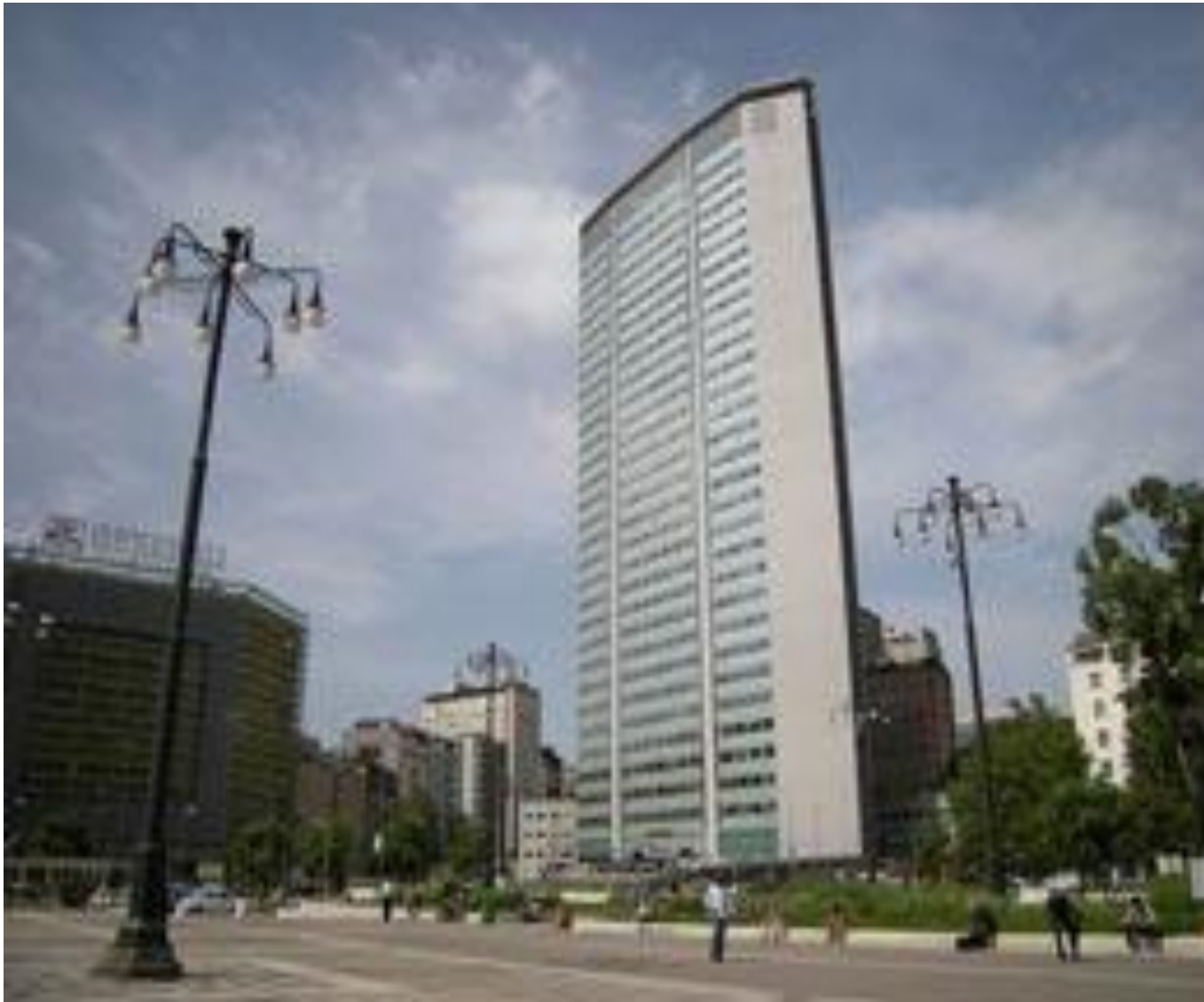
Конторское здание фирмы Пирелли в Милане, арх. Д. Понти, инж. Нерви, 1959
