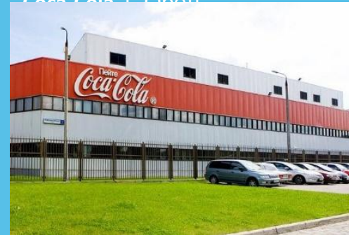
Реконструкция завода Coca-Cola г. Орёл
