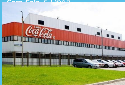
Реконструкция завода Coca-Cola г. Орёл
