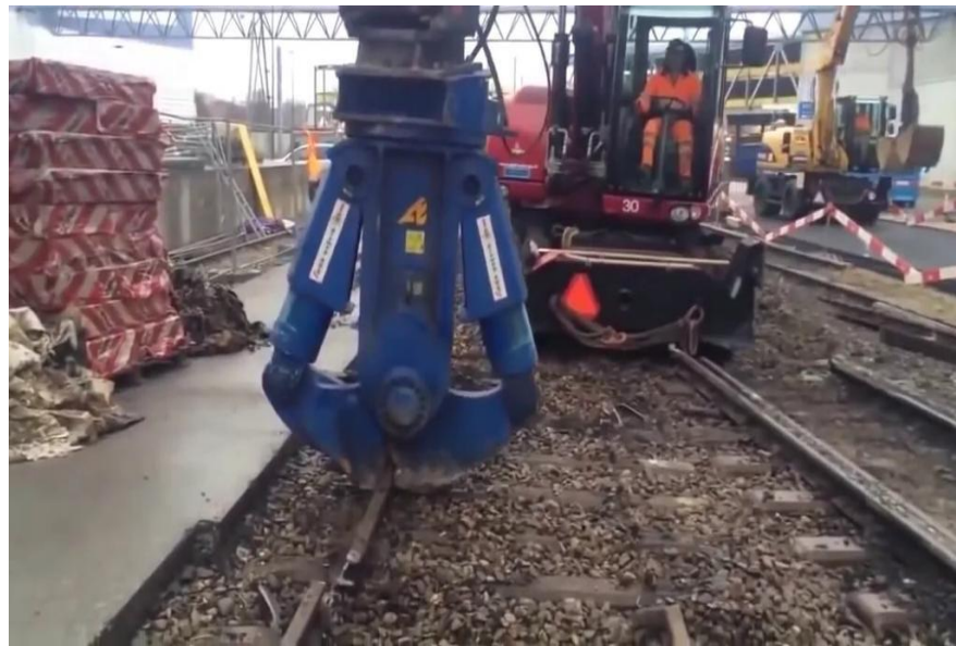
Участки ремонтно-путевых работ
