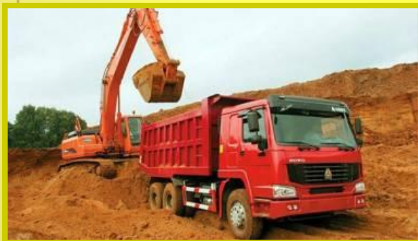
Глина добывается экскаваторами...
