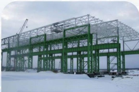
Металлоконструкции каркасов зданий
