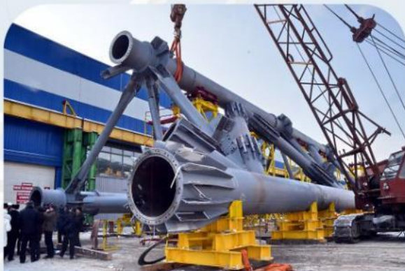
Уникальные конструкции из трубы
