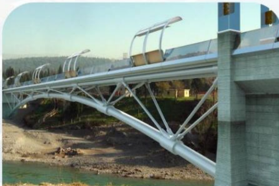
Металлоконструкции мостов, путепроводов, эстакад
