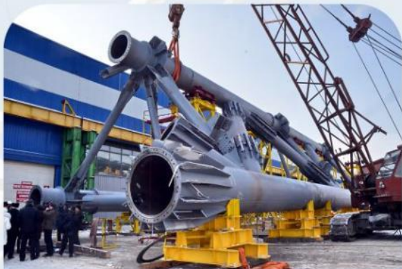
Уникальные конструкции из трубы
