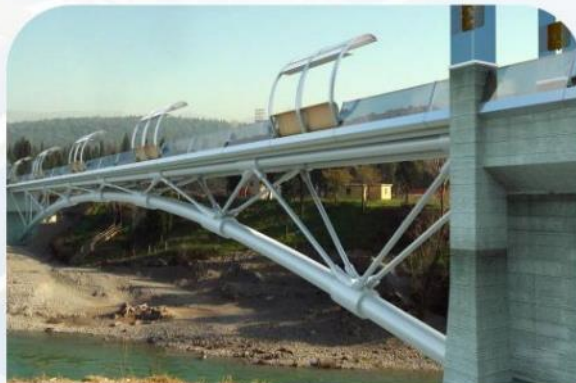
Металлоконструкции мостов, путепроводов, эстакад
