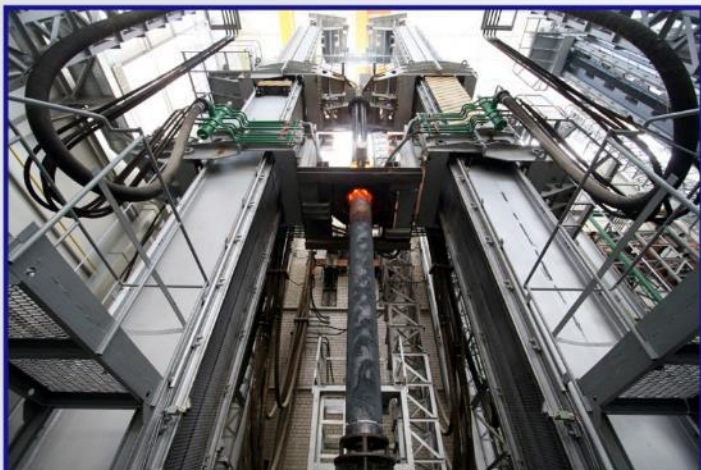
Печь электрошлаковой выплавки трубной заготовки
