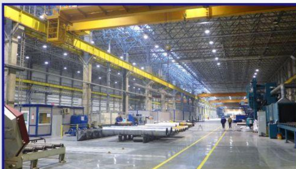
Новый корпус производства трубопроводов 45000 кв.м. с единой производственной цепочкой, 1500 тонн в месяц
