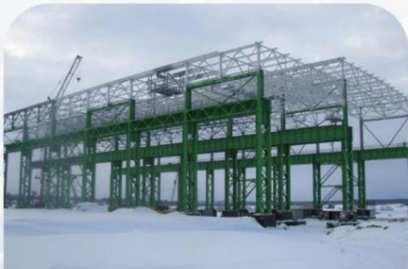
Металлоконструкции каркасов зданий
