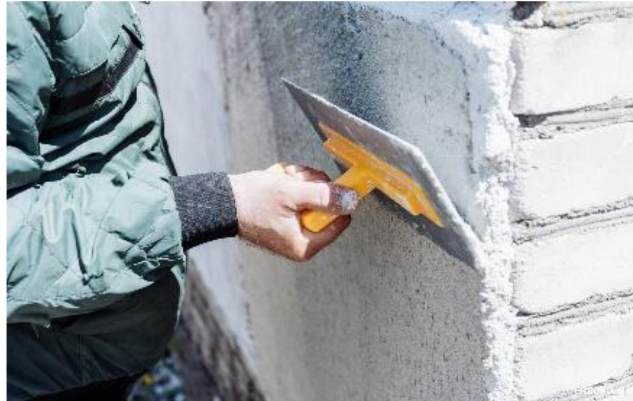
Энергосберегающую штукатурную смесь применяют как в качестве утепляющей фасадной штукатурки, так и для внутренней отделки помещений. Энергосберегающая штукатурка сочетает в себе достоинства утеплителя и декоративной штукатурки.
