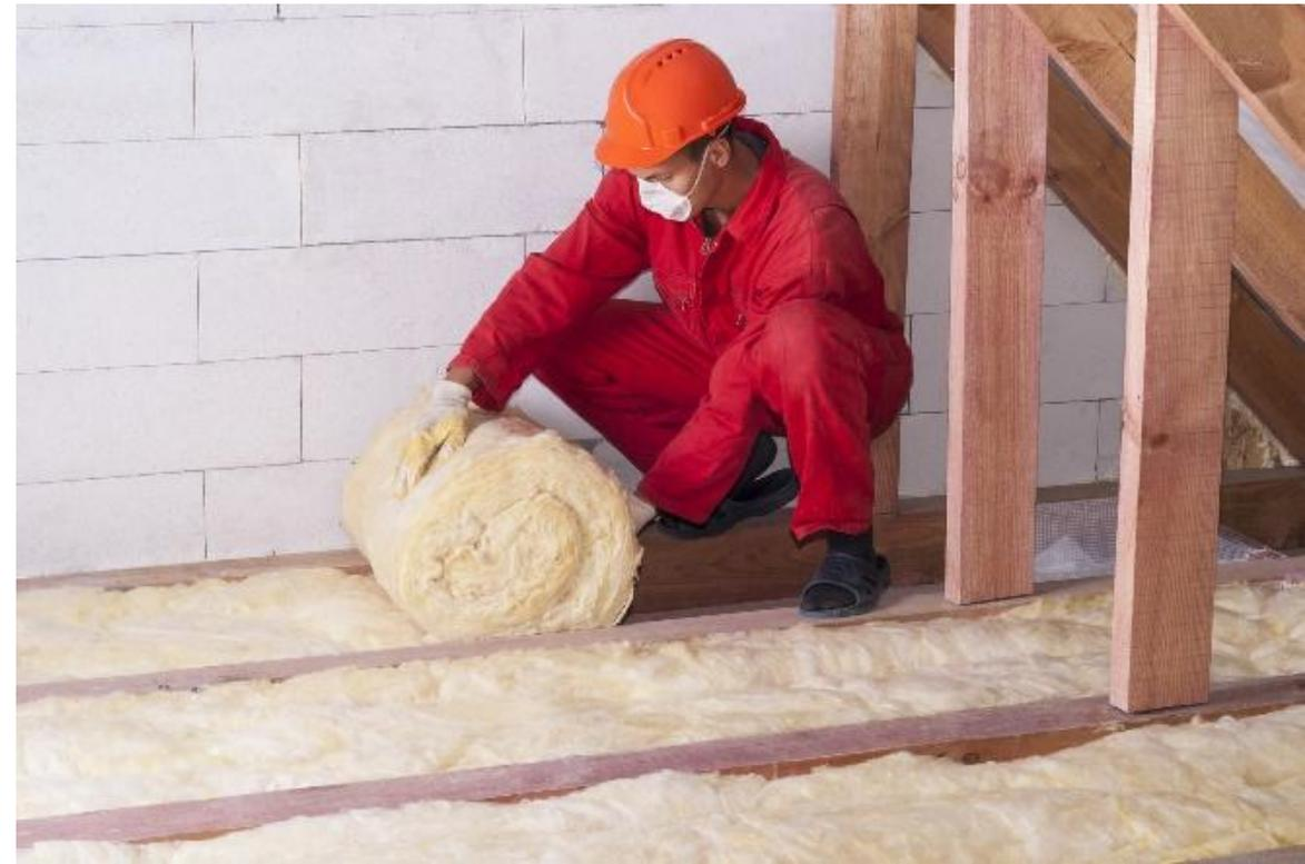
Минеральная вата ценится своими высокими параметрами химической устойчивости, отличными тепло- и звукоизоляционными свойствами - она лучше других материалов поглощает звуковые волны. Но у минеральной ваты есть один серьезный недостаток – повышенная паропроницаемость, поэтому ее рекомендуют использовать только в комплекте с гидроизоляционными материалами.
