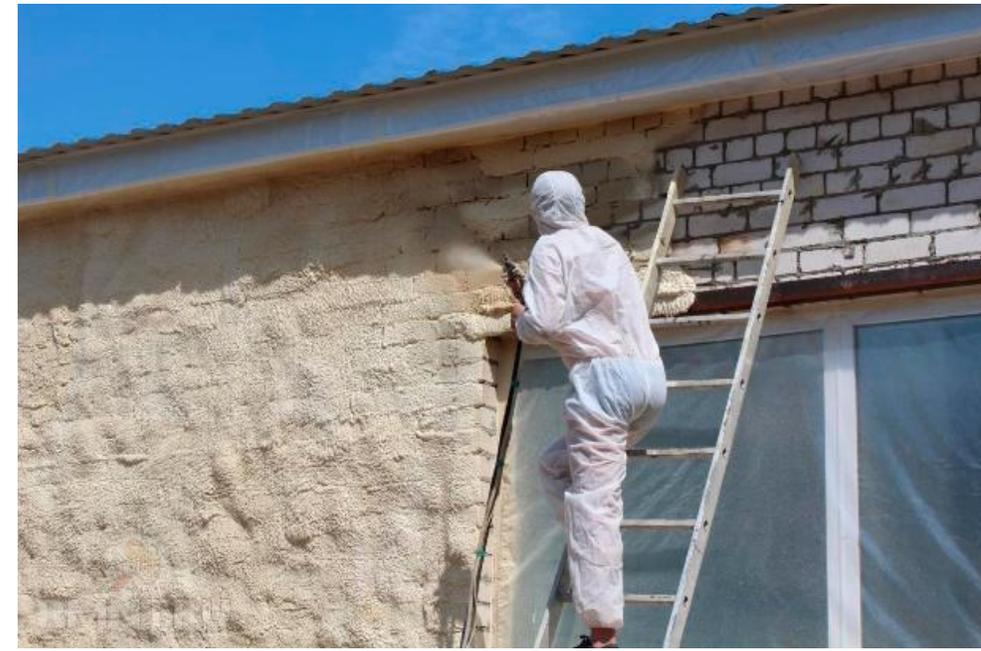
Пенополиуретановые материалы бывают жесткие, полужесткие и эластичные. Для применения полиуретанов в теплоизоляционных работах используют множество методов – экструзию, прессование, литье, заливка, напыление и т.д.
