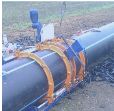
Сварка и укладка ПЭТ труб в траншеи
