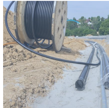
Монтаж кабеля 20кВ
