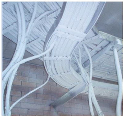
Обработка кабеля огнезащитным составом
