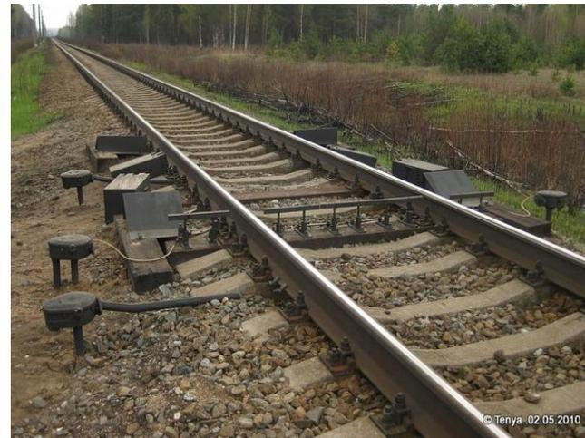
При разрушении датчика волочащимися деталями, либо при сходе железнодорожного состава, срабатывают контрольные приборы
