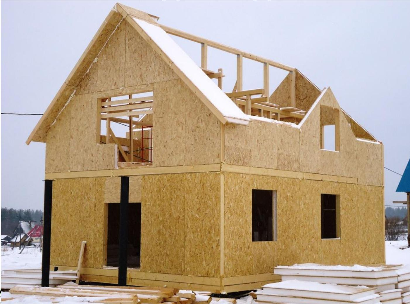
**Деревянный брус** — обеспечивает дополнительную несущую способность каркаса дома. Соединяет панели. Стыки между брусом и панелями уплотняются монтажной пеной.
