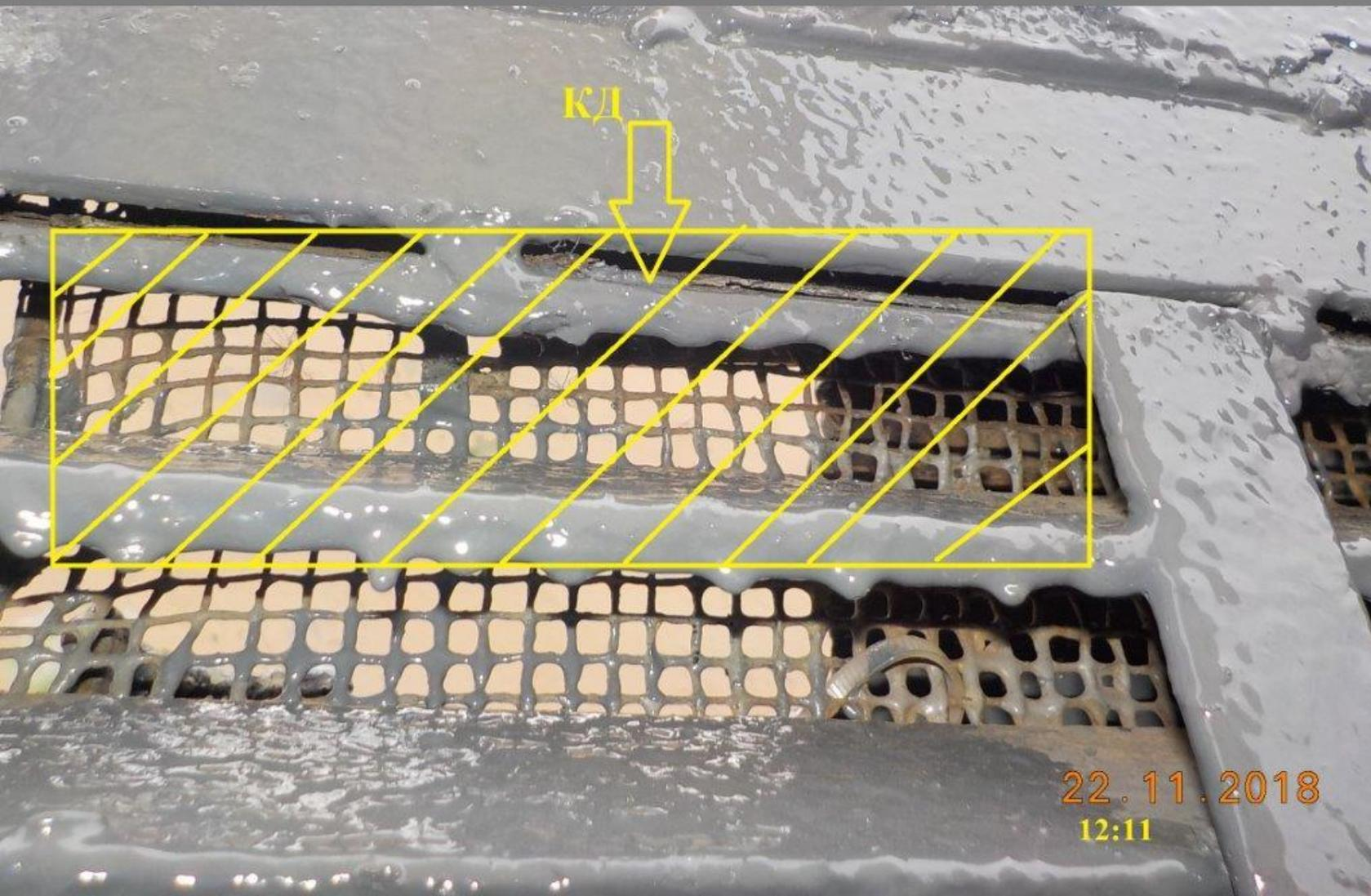
22.11.18. ТСС5. ВКК Тропарево-Никулино-7. ПК0 (Аналогично: ПК7, ПК6, ПК3Г2) – необходимо установить (наварить) дополнительную боковую защитную пластину на защитный кожух ЗУ.
