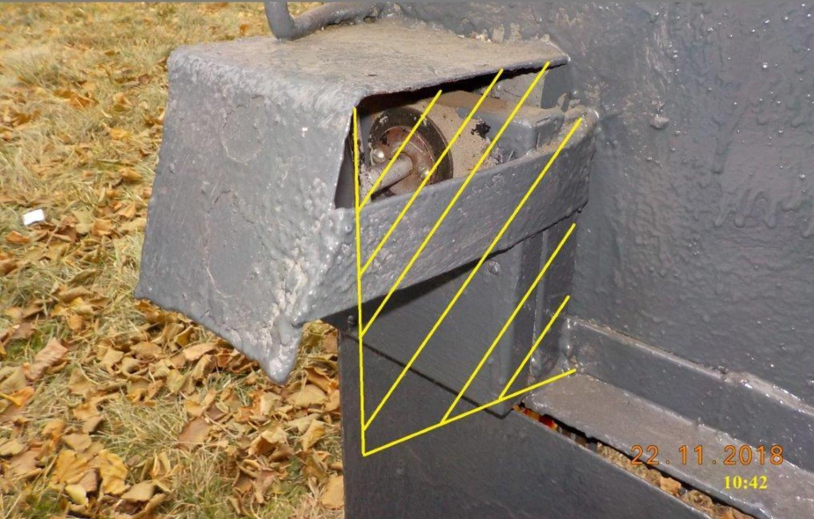
23.11.18. ТСС7. Сушецкий. ПК51 – повреждение закладной, отклонение от проектного положения кронштейна консолей.
