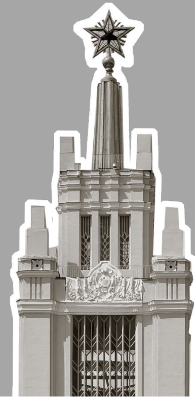
Башня павильона №59 («Московская область»)
