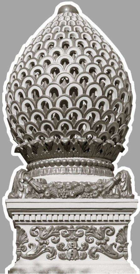
Декоративный колпак воздуховода павильона №1 (Центральный)
