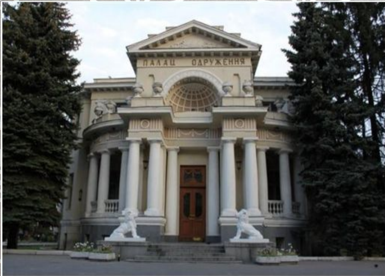
Колишній особняк А.А.Юзефовича, вул. Пушкінська, 61
