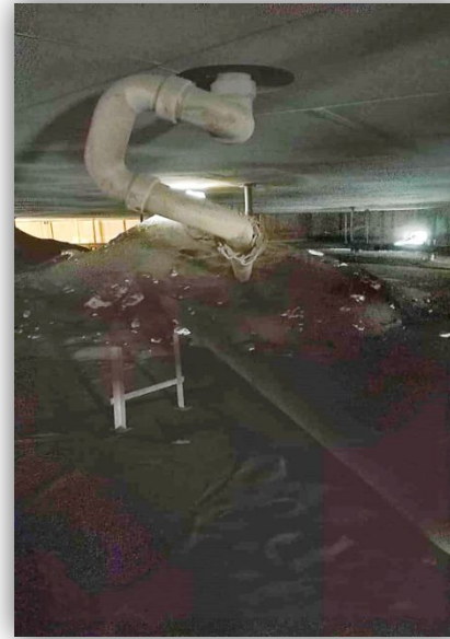
Дефект нарушения геометрии устройства водоспуска плавающей крыши
