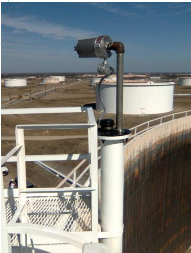
Установка в измерительном колодце
