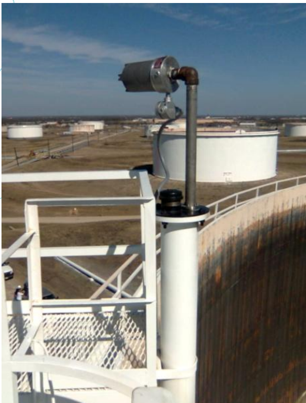
Установка в измерительном колодце
