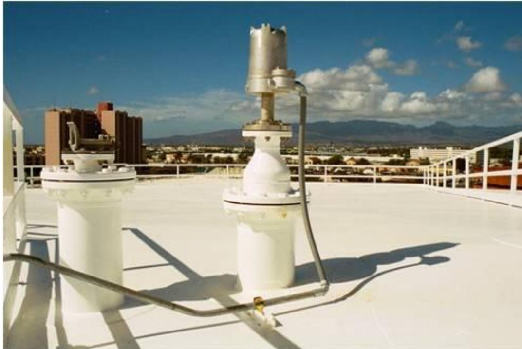
С целью увеличения надежности и точности измерений плотности и температуры продукта в системе MTG устанавливается до 12 сенсоров давления, в отличие от традиционных ГСИ, использующих до 3-х датчиков давления.
