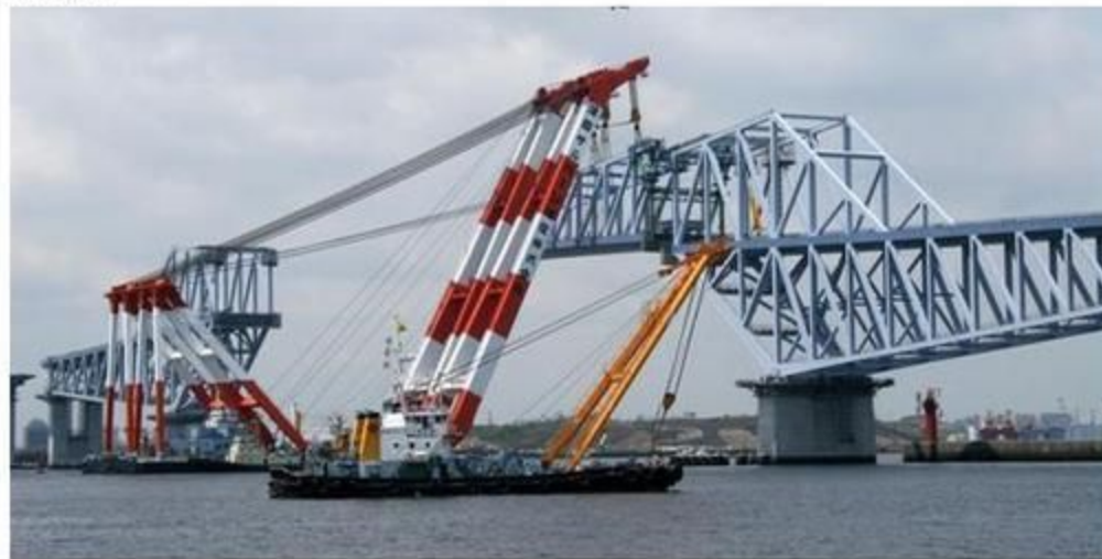
Монтаж секции моста с использованием плавучего крана
