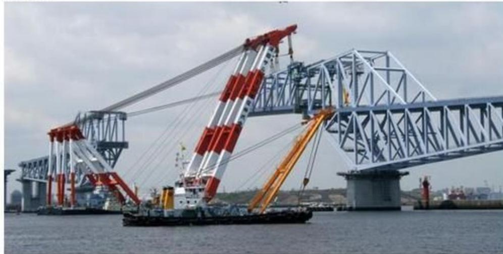
Монтаж секции моста с использованием плавучего крана
