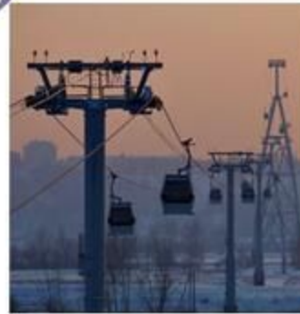
Кольцевая канатная дорога
