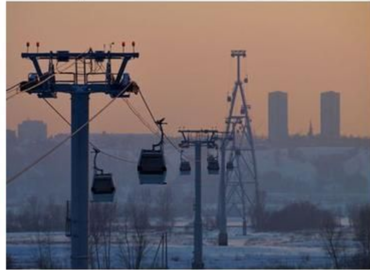
Кольцевая канатная дорога
