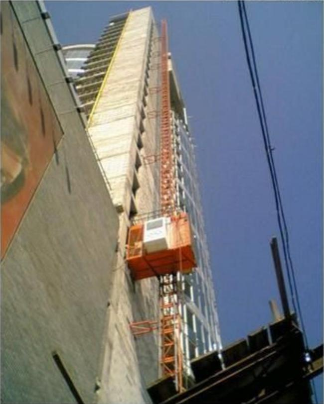
**Грузоподъемные машины** для периодического вертикального или близкого к нему подъема-опускания грузов и людей (пассажиров) — **подъемники (лифты)** — отличаются тем, что в них площадка или кабина, в которой размещаются грузы или (и) пассажиры, движется в жестких направляющих.
