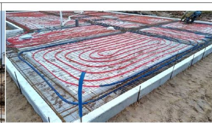
Фото №6 фундамент с коммуникациями
