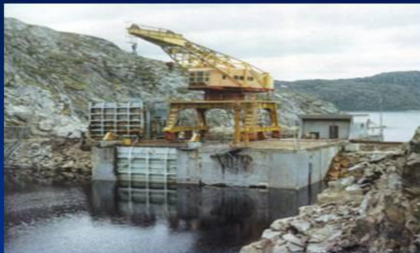
Кислогубская приливная электростанция.
