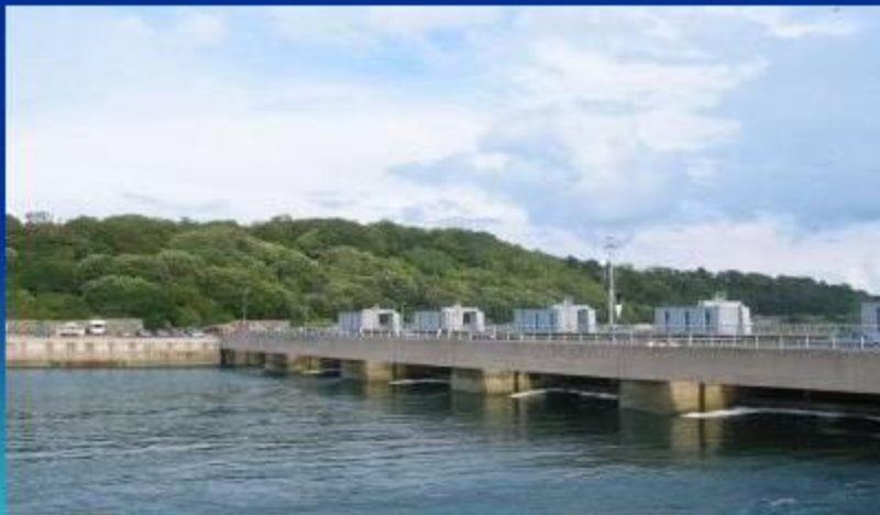
Крупнейшая в мире приливная электростанция Ля Ранс, Франция
