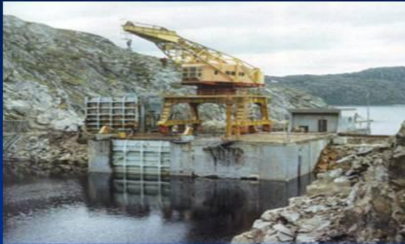
Кислогубская приливная электростанция.
