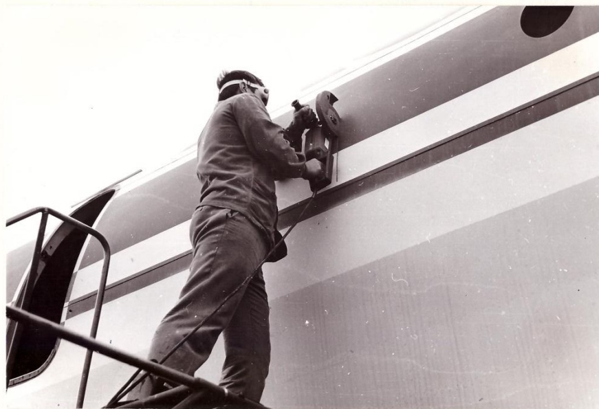
Резка фюзеляжа электрическими углошлифовальными машинами / армированный абразивный круг \Phi 230 мм/ МА-1800 произ- водства Болгария завод "ЕЛпром".
