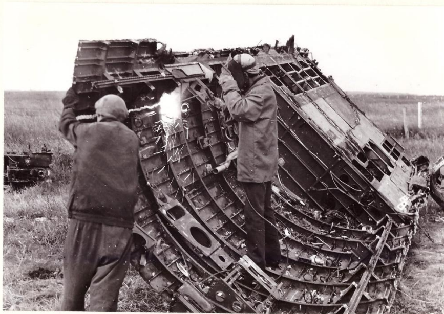
Разделка на фрагменты при помощи электросварки электродами.
