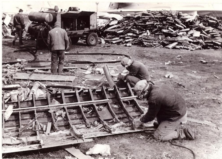
Разрезка панелей фюзеляжа на фрагменты ручными пневматическими машинами МПС-2215.
