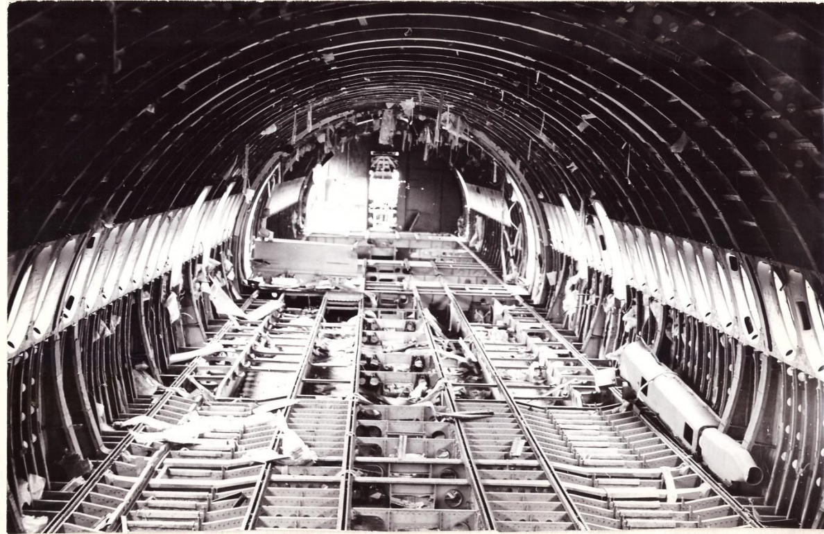
Пассажи́рский салон самолета Ил-62 после демонтажа оборудования /подготовка к разделке в металлолом/.
