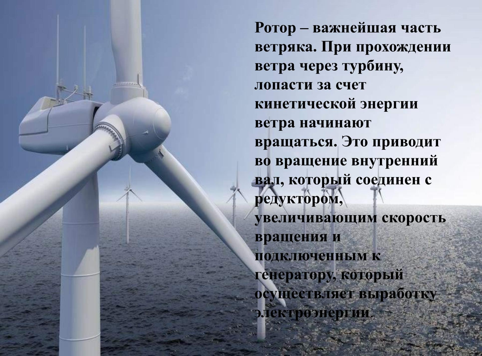
**Ротор – важнейшая часть ветряка. При прохождении ветра через турбину, лопасти за счет кинетической энергии ветра начинают вращаться. Это приводит во вращение внутренний вал, который соединен с редуктором, увеличивающим скорость вращения и подключенным к генератору, который осуществляет выработку электроэнергии.**
