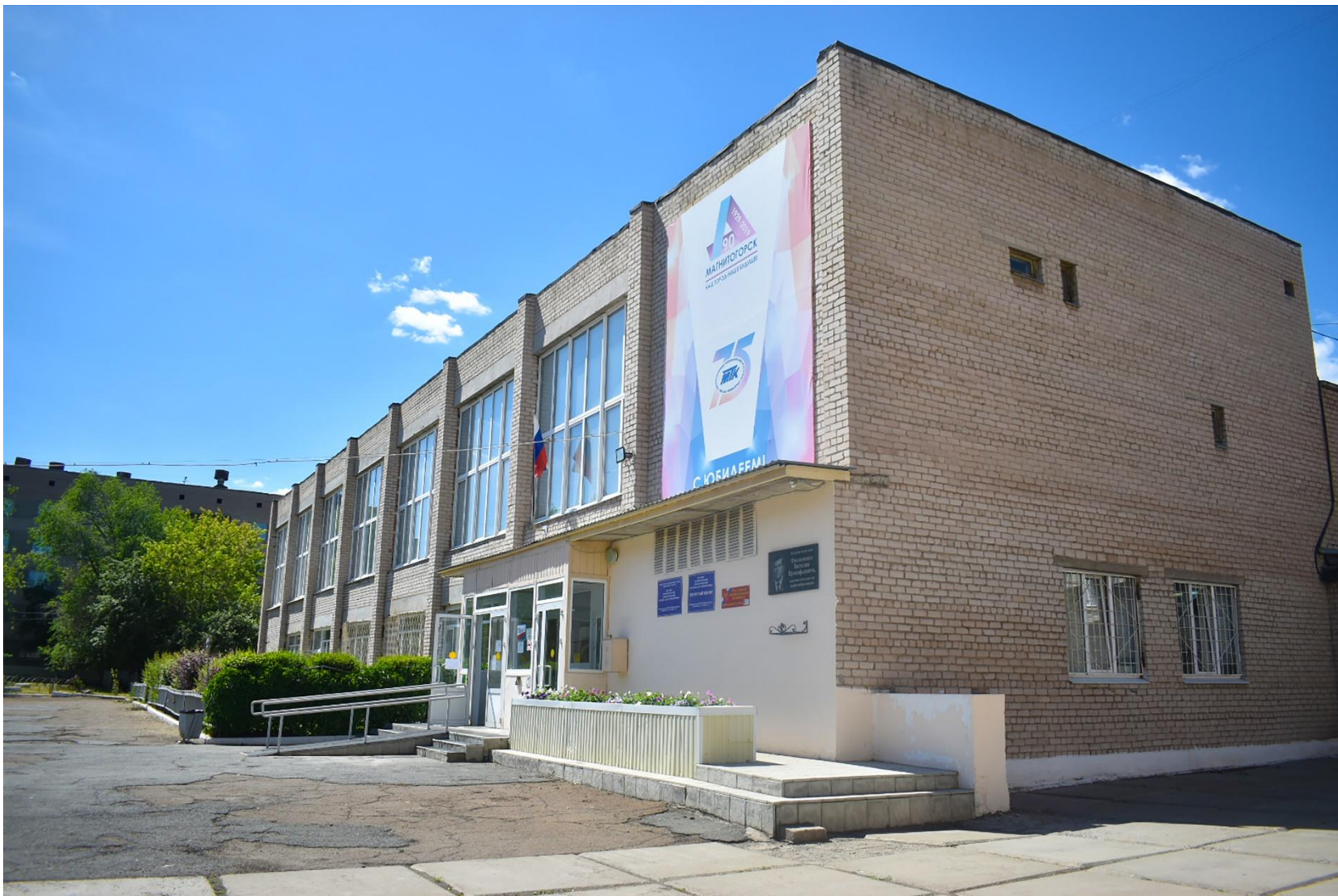
Фото №1 Ул. Сталеваров 11
