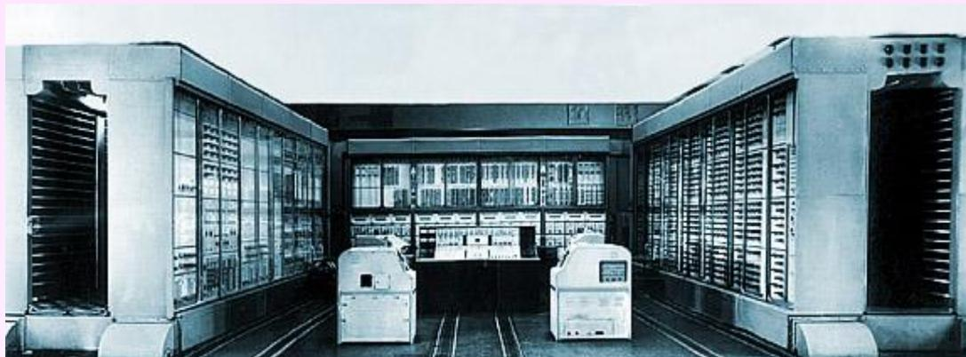
Базилевский Ю.Я. разработал цифровую вычислительную машину общего назначения "Стрела" с быстродействием в 2 тысячи операций в секунду. Эта машина выпускалась до 1956 года, а всего было сделано 7 экземпляров. Таким образом, "Стрела" была первой промышленной ЭВМ, — МЭСМ, БЭСМ существовали в то время всего в одном экземпляре.
