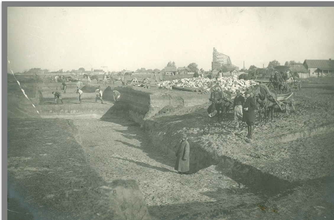
Строительство ТЭЦ-1 в 1930 году
