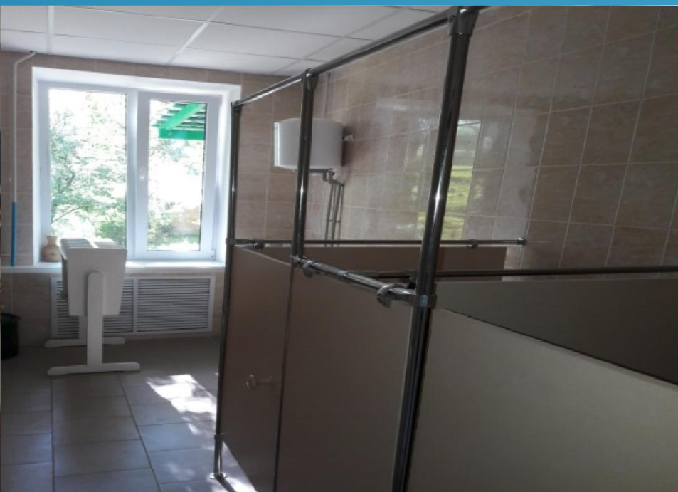
Санитарная комната Детского сада №3 г.Дмитриева после ремонта
