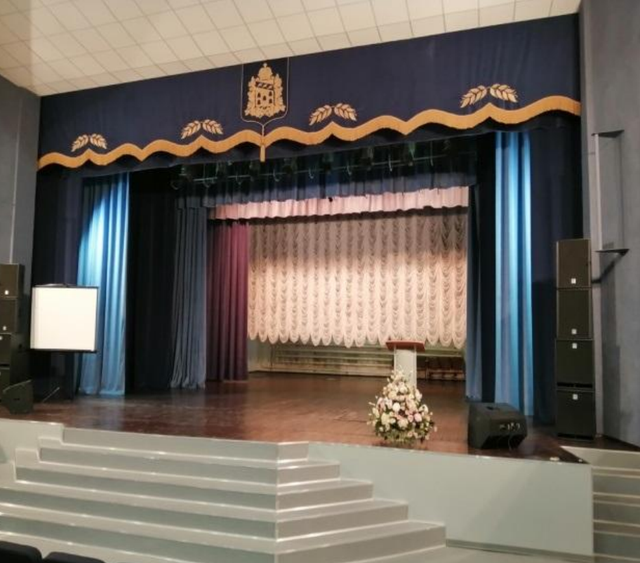
Капитальный ремонт сцены районного Дома культуры
