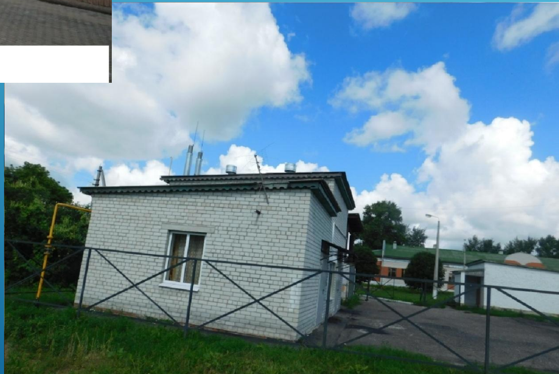
Строительство газовой котельной для Селинской средней школы Дмитриевского района
