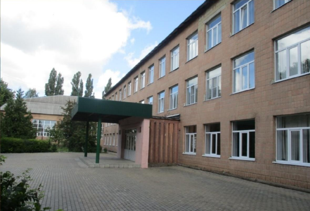
Проведен ремонт с заменой оконных блоков в средней школе №2 г.Дмитриева
