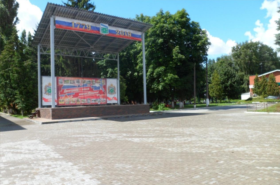
Строительство новой сцены на обновленной центральной площади г.Дмитриева
