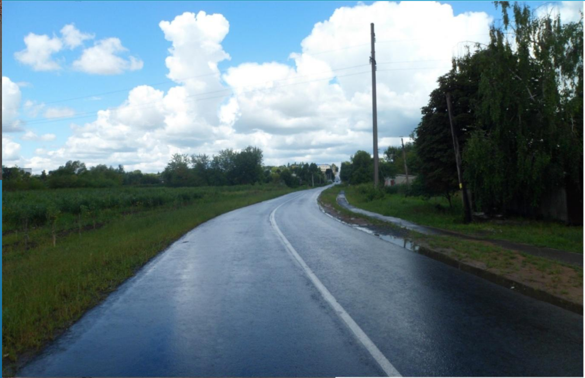
Построен новый участок автодороги на въезд в г.Дмитриев
