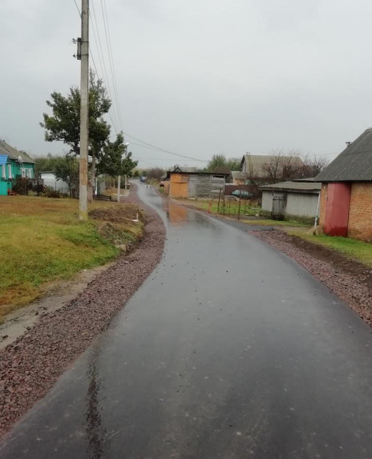
Строительство участка автодороги по д.Ладыгино Крупецкого сельсовета
