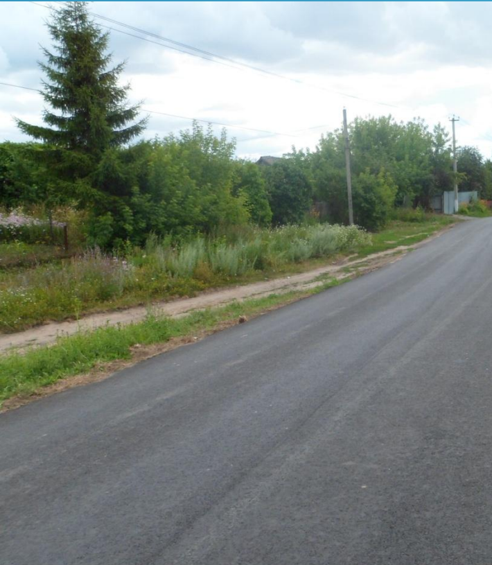
Капитальный ремонт участка автодороги въезда в г.Дмитриев через с.Крупец
