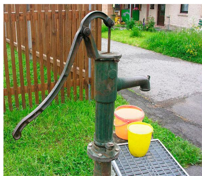
Трубчатые колодцы (скважины)
