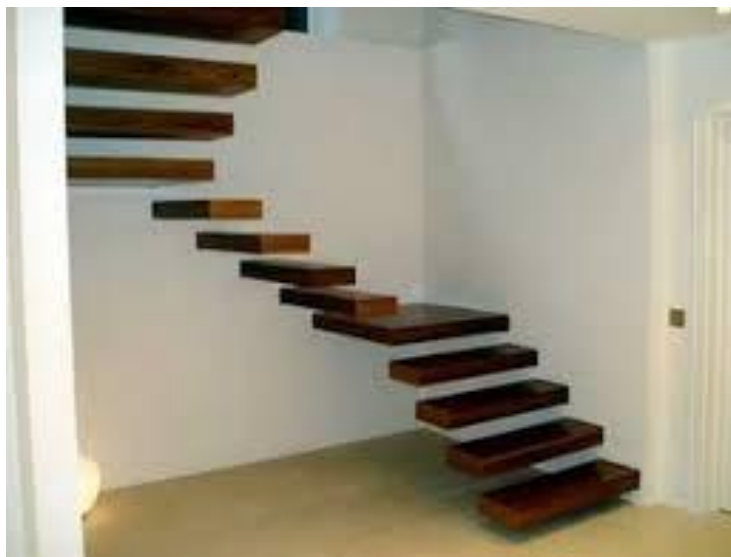
лестница на больцах (от нем. «штырь»), ступени крепятся в стене
