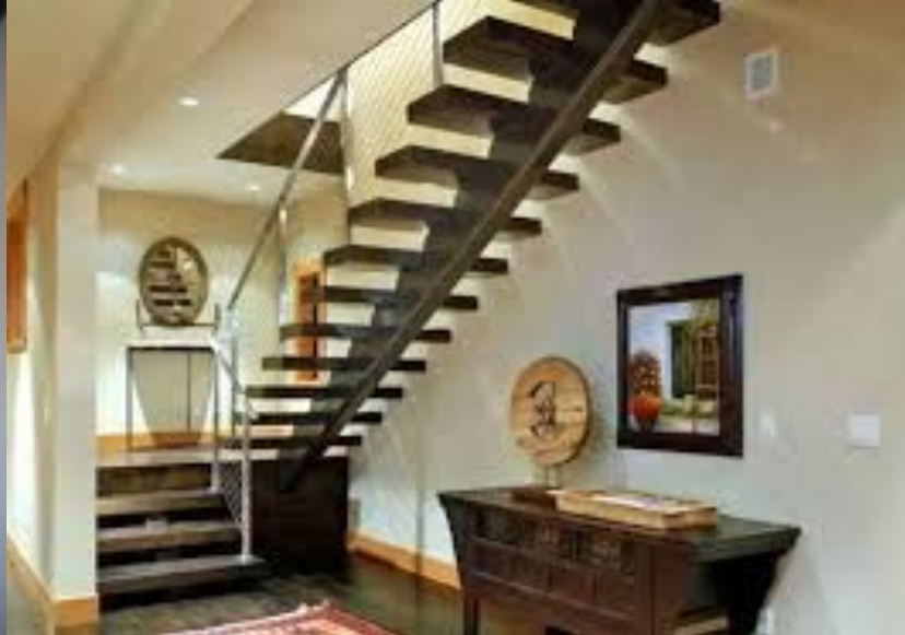
лестница на косоурах (балках), по которым укладываются ступени лестница
