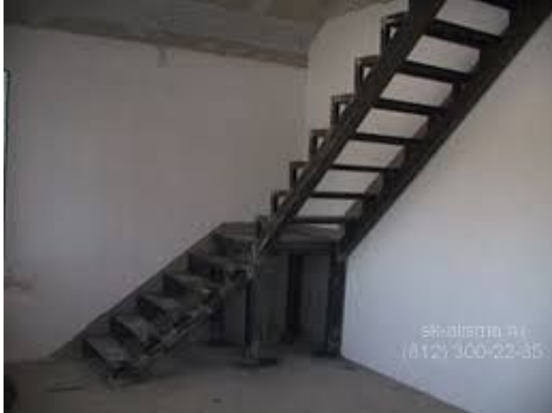
лестница на косоурах (балках), по которым укладываются ступени лестница
