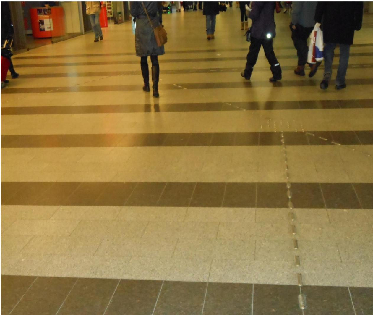
Финляндия. Тактильные направляющие и предупреждающие элементы из металла. Разметка в торговом комплексе. Ширина- 30мм. Высота- 3мм.
