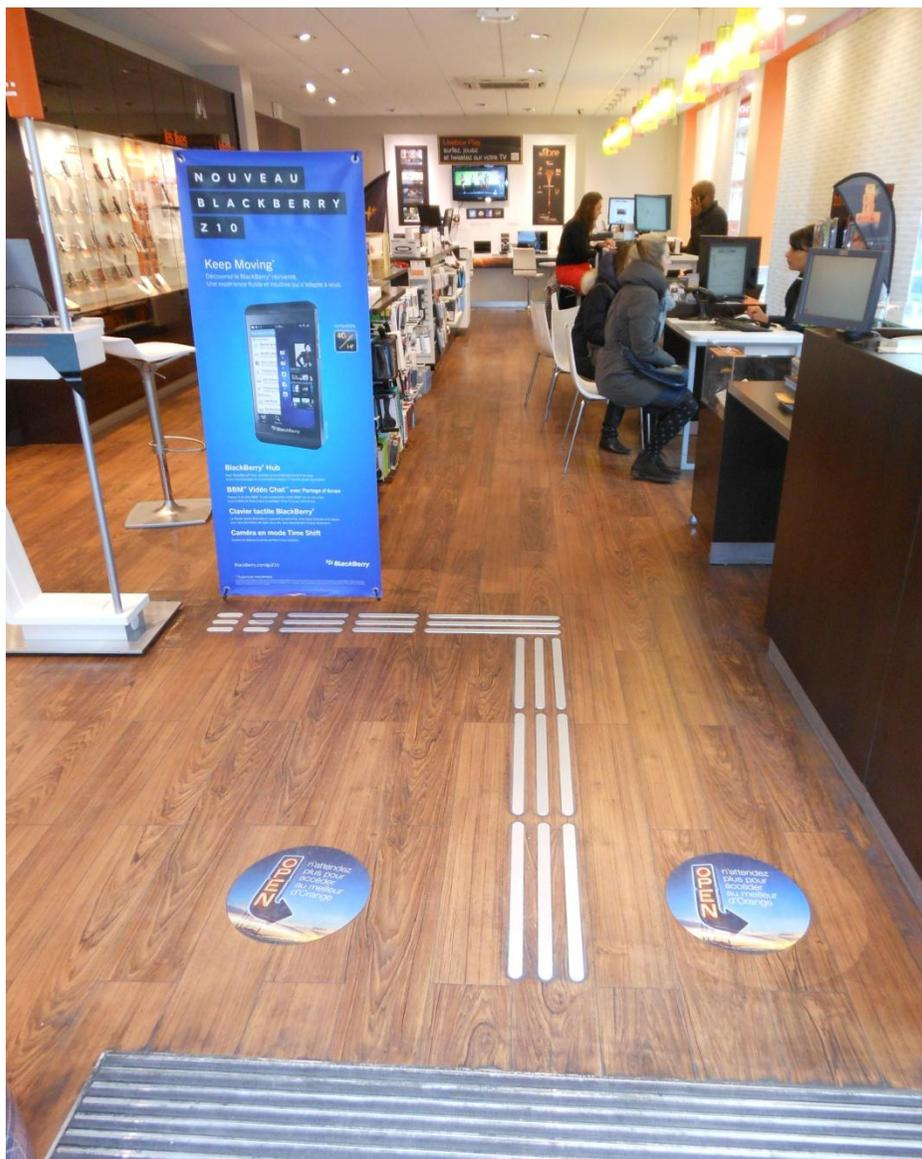
Франция. Все салоны связи «ОРАНЖ» оборудованы металлической тактильной разметкой, направляющей посетителя с нарушением зрения к стойке с оператором. Высота тактильных элементов- 3мм. Ширина тактильных элементов- 30мм. Общая ширина тактильной дорожки-150мм.
