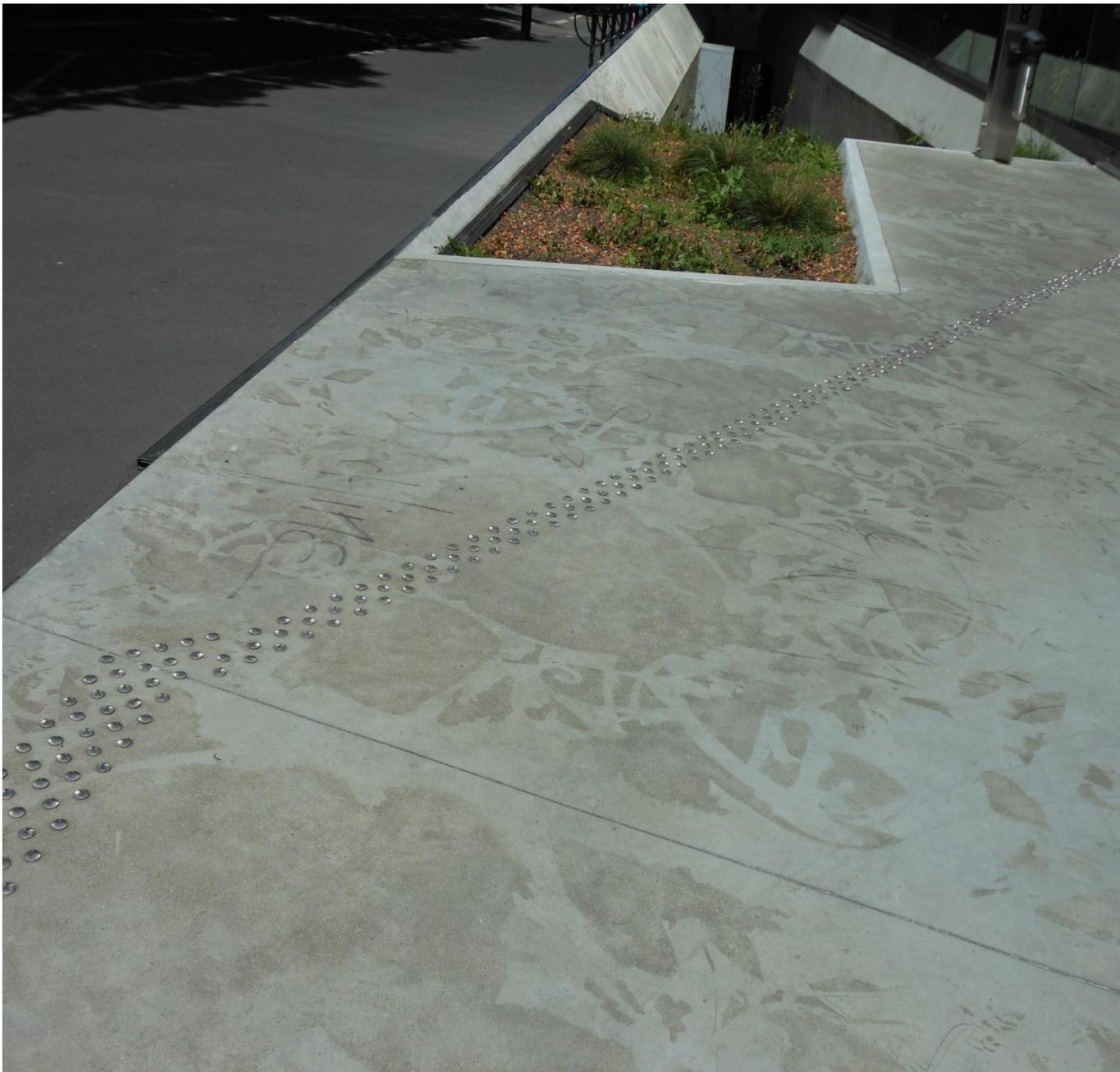
Франция. Пример использования металлических индикаторов, предупреждающих о препятствии, на улицах городов. Высота тактильных элементов- 3мм. Диаметр тактильных элементов- 25мм.
