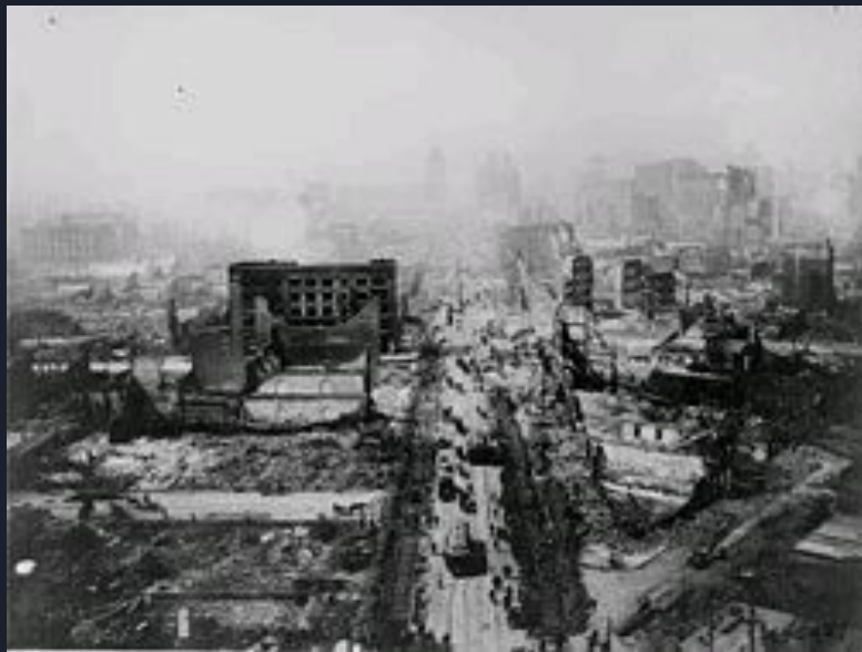
Последствия катастрофического землетрясения в Сан-Франциско, США, в 1906 году
