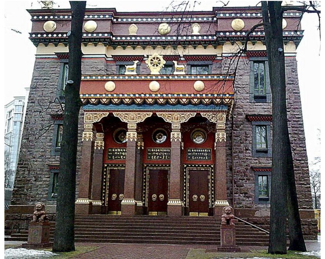
Буддийский храм, 1909г., арх. Барановский.
