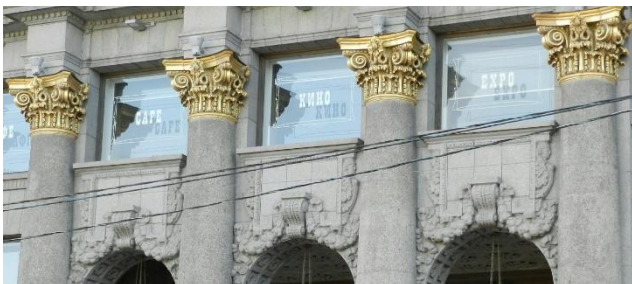
Особняк фон Дервизов на Английской набережной, 1883-1885 гг., арх. А. Красовский.
