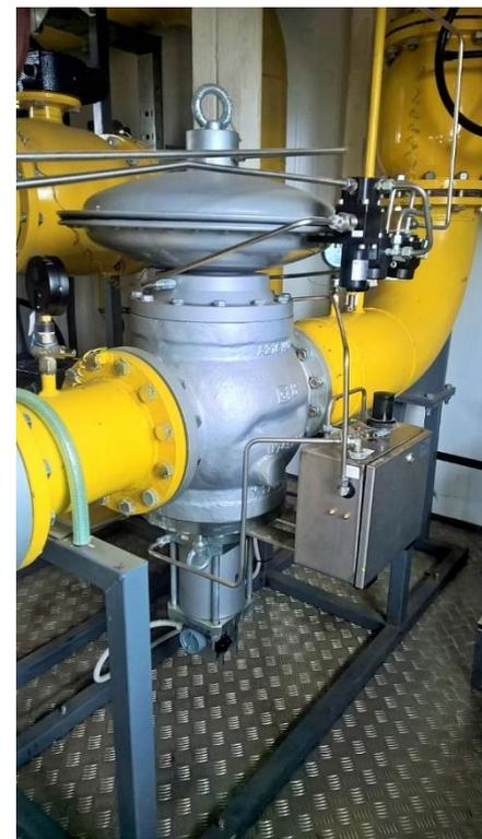
В системах дистанционного управления и контроля активно применяются **системы FIO**, позволяющие контролировать и регулировать подачу газа одновременно по пяти параметрам
