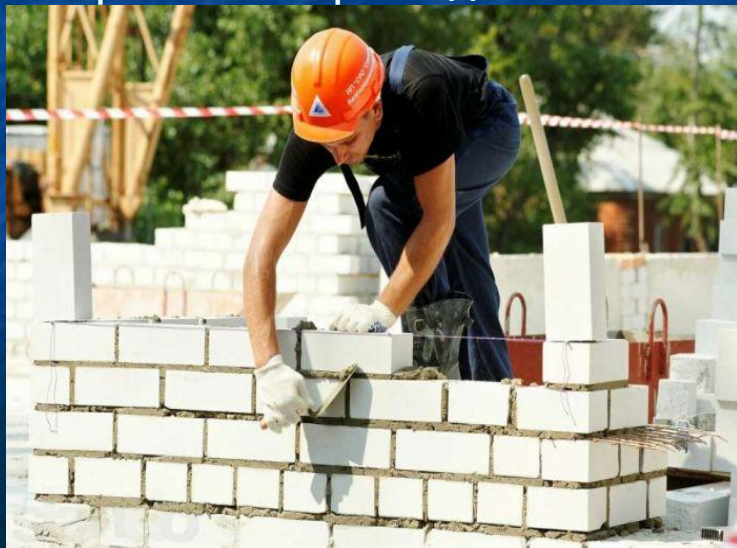
7. Строитель строит дом
