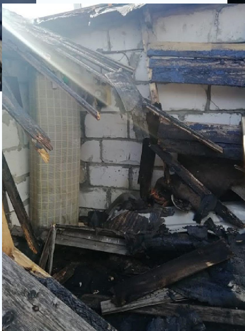
Гараж, назначение: нежилое помещение, Республика Коми, г. Сыктывкар, ул. Станционная, д.92.
