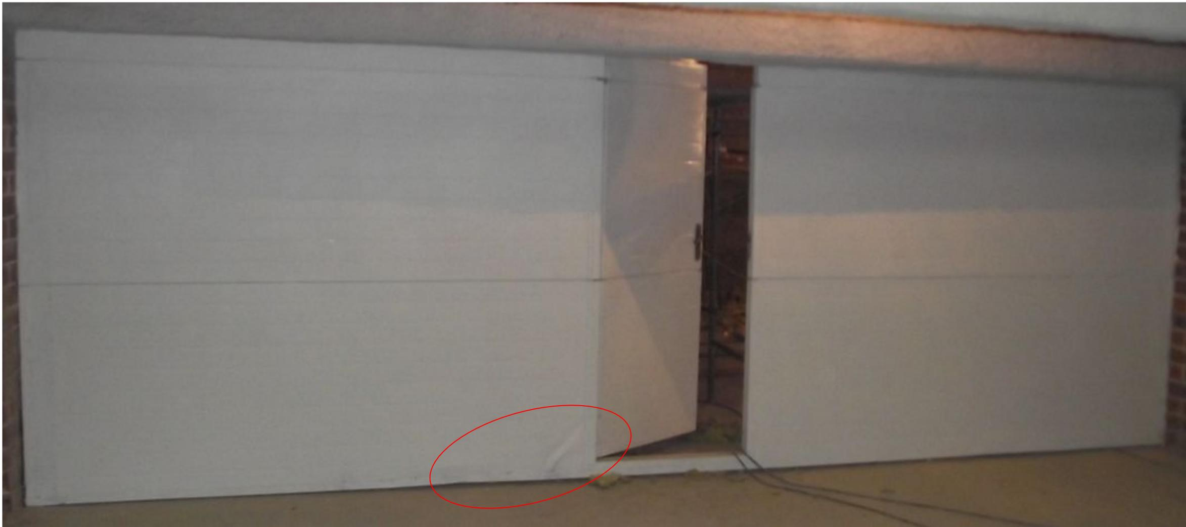
Щели видны во всех конструкциях, отсутствует термо-уплотнитель.
