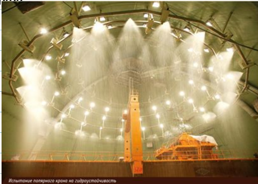
Испытание пожарного крана на гидроустойчивость
