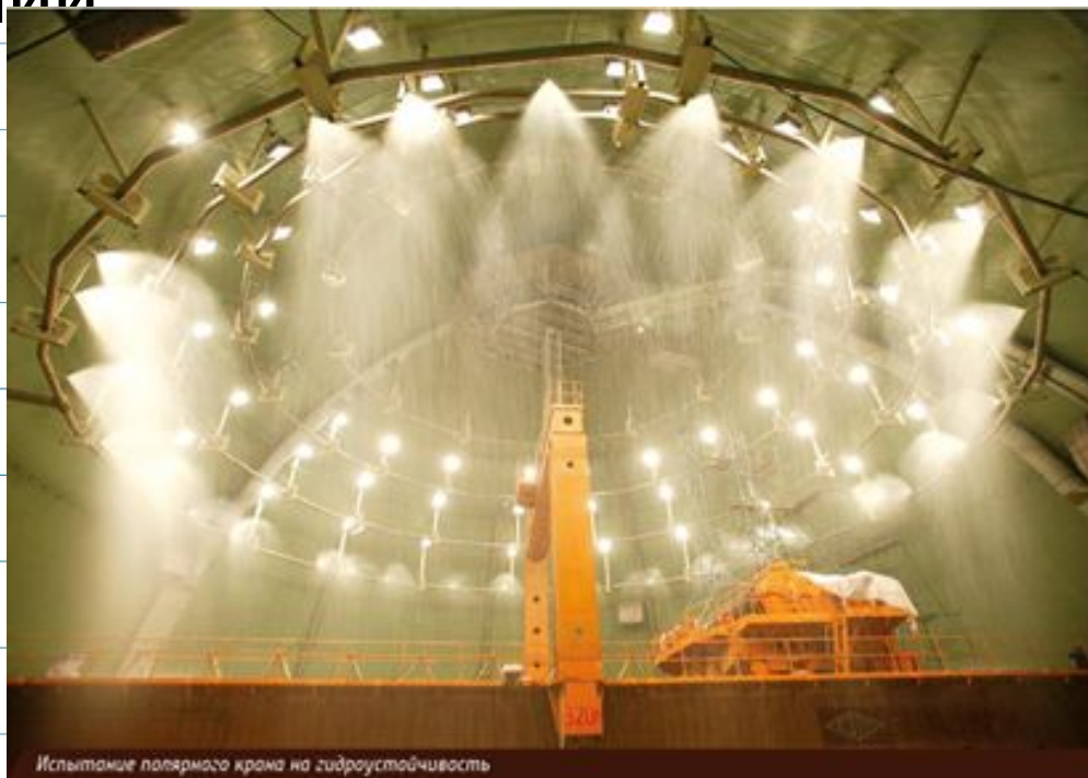
Испытание пожарного крана на гидроустойчивость
