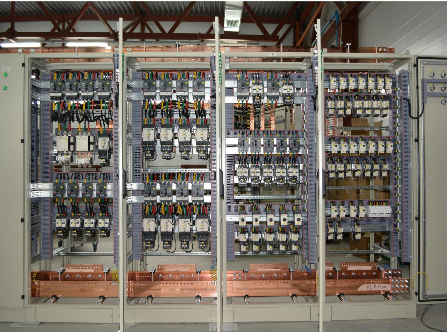
ЭРУ - называют электроустановку, служащую для приема и распределения электроэнергии и содержащую коммутационные аппараты, сборные и соединительные шины, вспомогательные устройства (компрессорные, аккумуляторные и др.), а также устройства защиты, автоматики и измерительные приборы.
