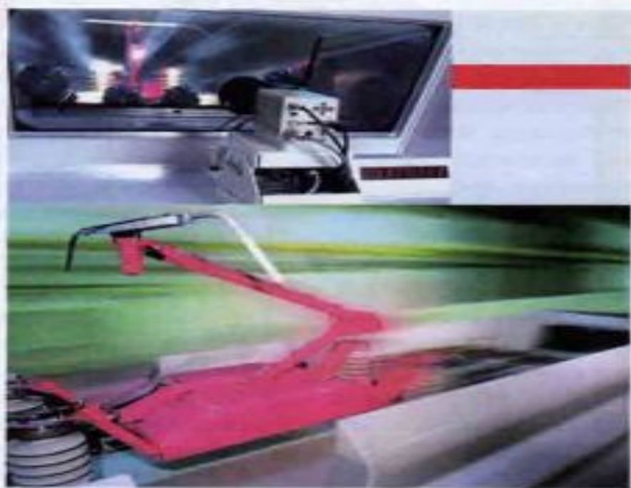
Рис. 20.8. Контроль состояния контактной подвески и процесса токобъема: а, б — устройства лазерного сканирования положения контактного провода; в — пост наблюдателя за работой токоприемника и контактной сети (врезка) и общий вид токоприемника
