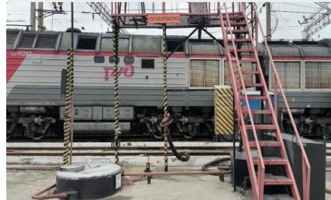
Эстакада для слива дизельного топлива
