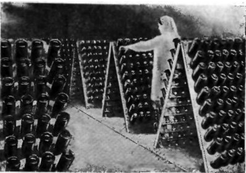
Рис. 169. Сведение осадка на пробку (ремюаж) на шампанском заводе «Аббав-Дюссо».
