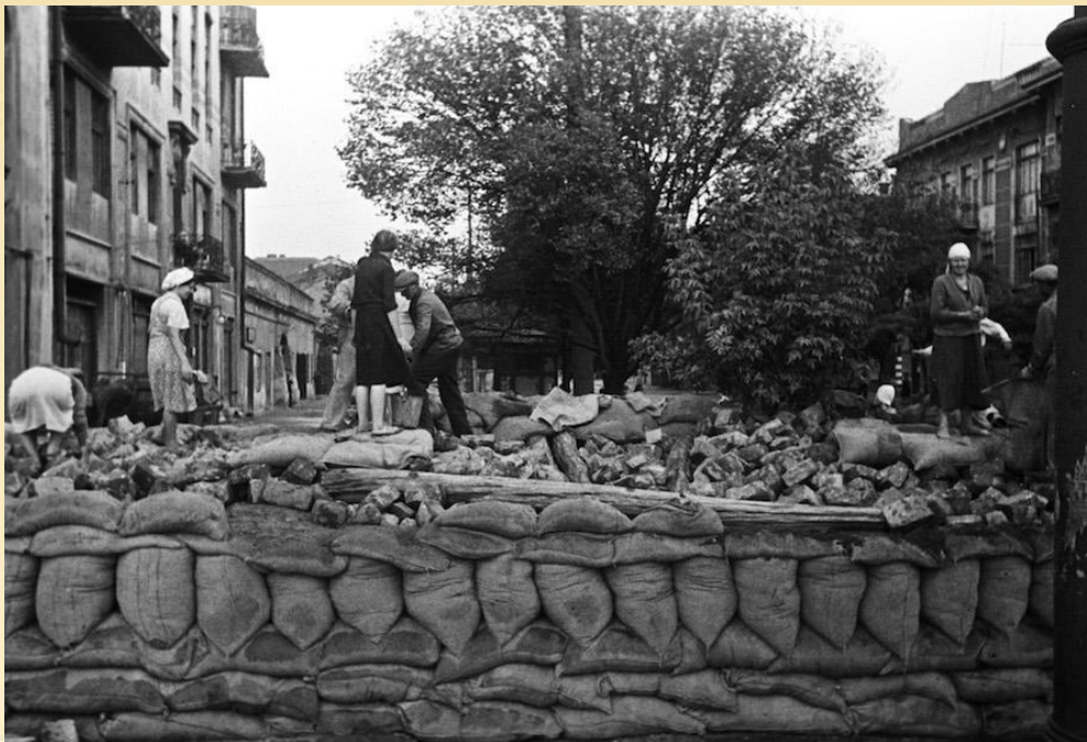
Жители Одессы во время строительства баррикад.
