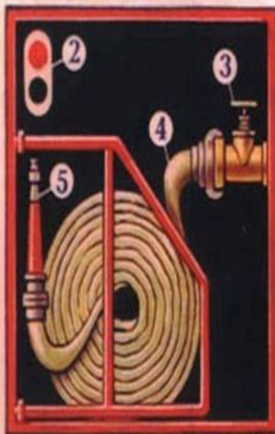
ПРЕДНАЗНАЧЕН для тушения пожаров и загораний веществ и материалов, кроме электроустановок под напряжением
