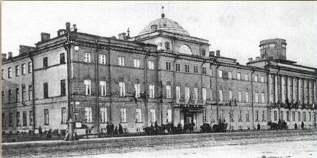
Морской Кадетский корпус, г. Санкт-Петербург
