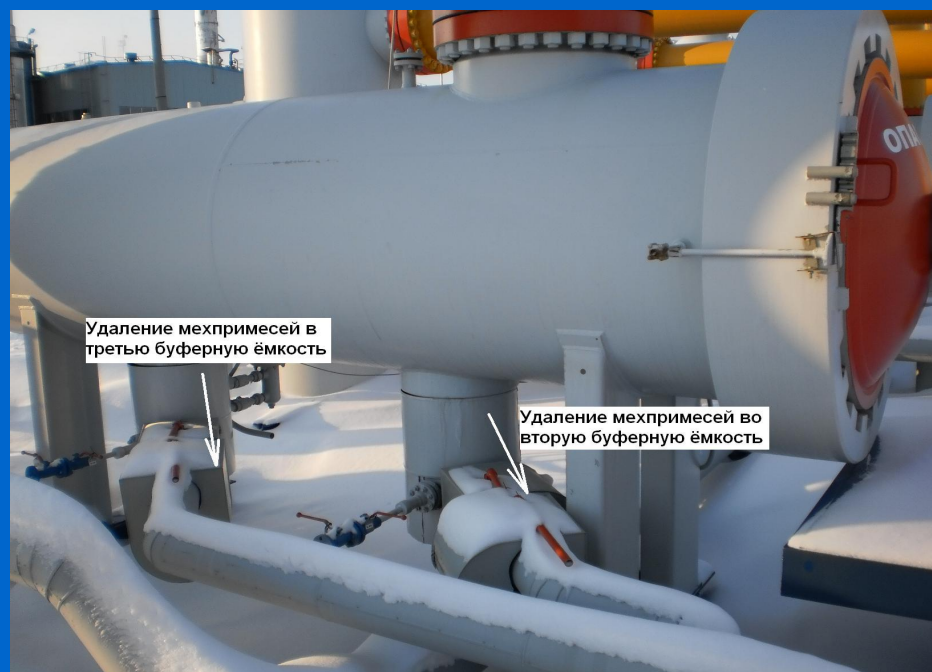
Направления продувочных дренажных трубопроводов горизонтального сепаратора
