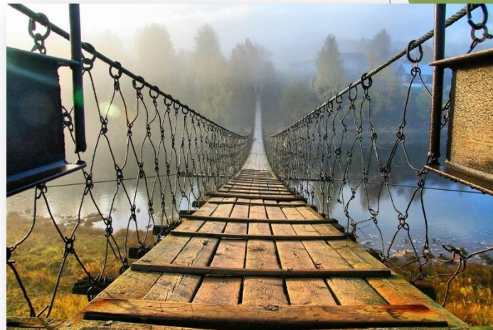
Мост через Усьву, Пермский край.
