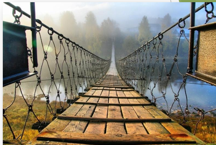
Мост через Усьву, Пермский край.
