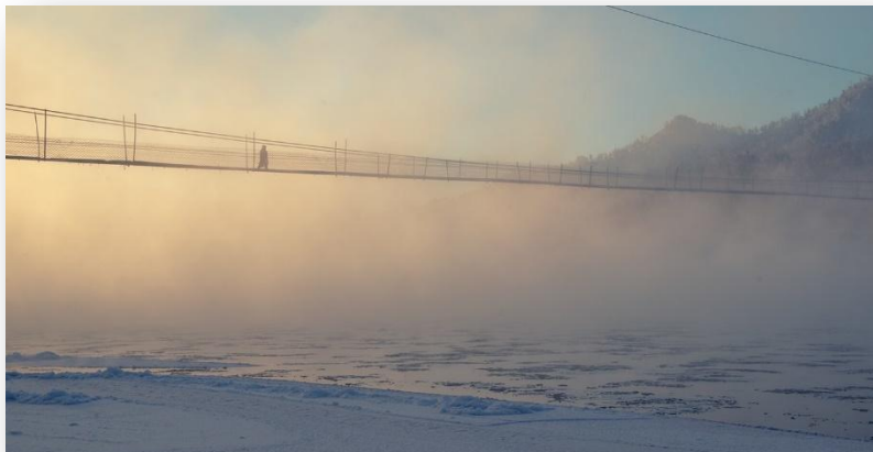
Пешеходный мост через реку Катунь у села Анос. Это одна из немногих переправ, сохранившихся после наводнения 2014 года.
