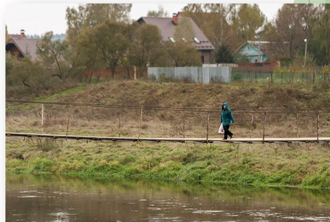
Подвесной мост через реку Москва в Тучково
