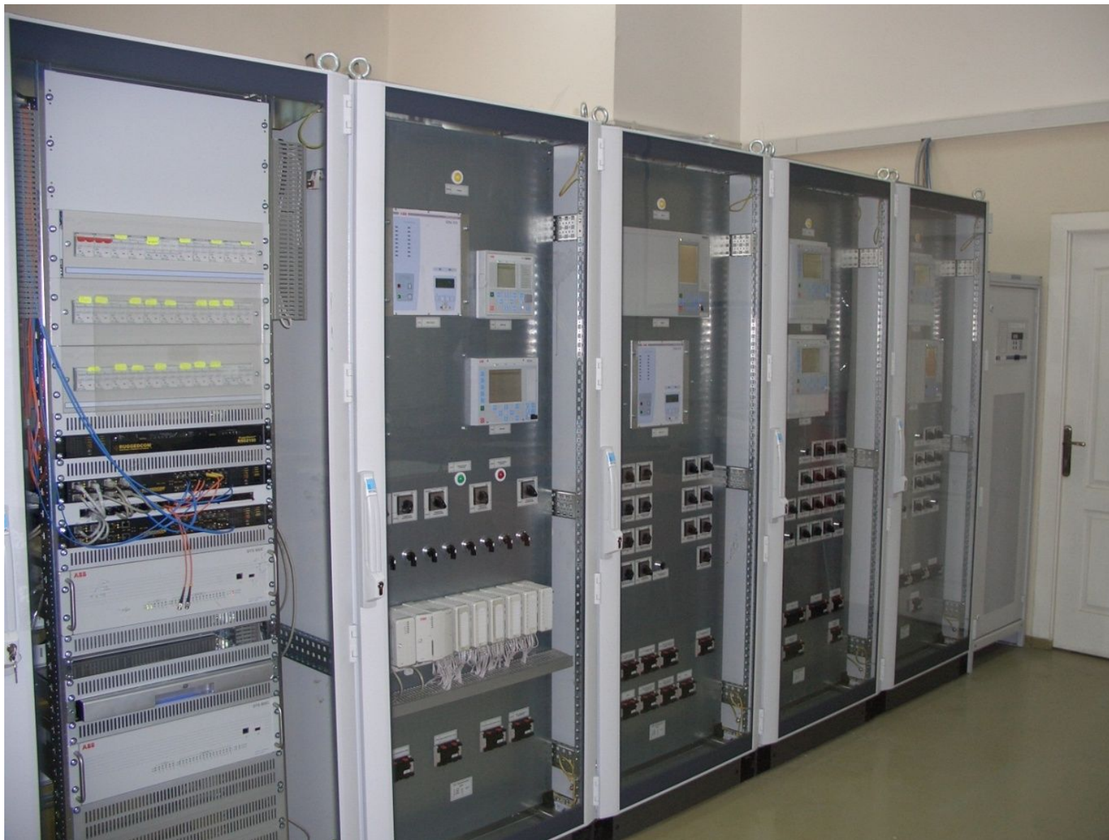
Шкафы управления и защит лаборатории АСУ ЭТО
