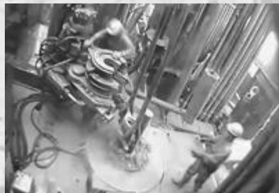
Перелив бурового раствора
