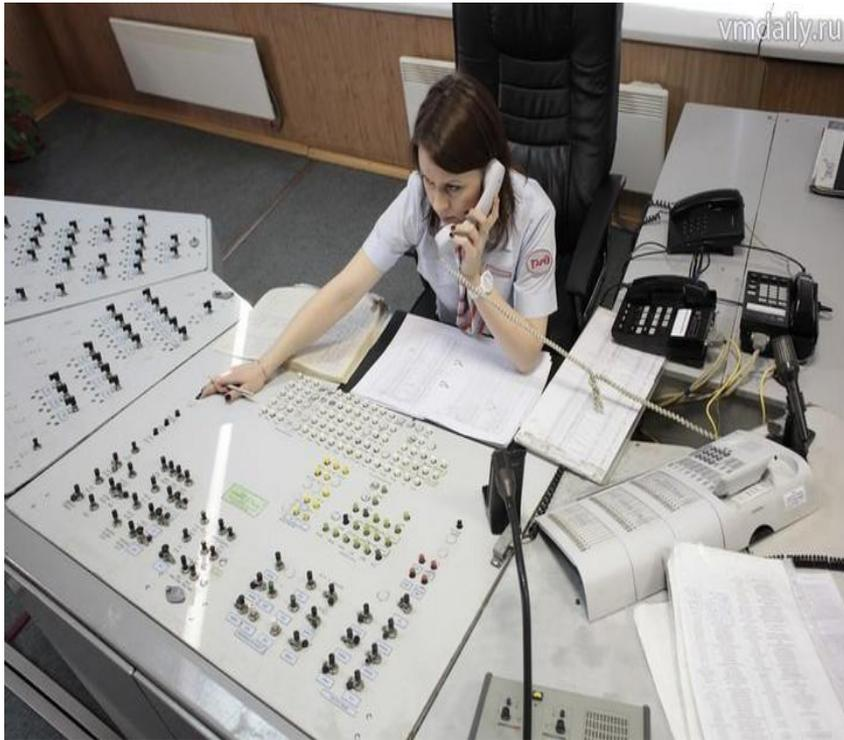
При наличии устройств автоматического контроля прибытия поезда на железнодорожную станцию в полном составе ДСП станции после прибытия поезда убеждается в свободности перегона по индикации на аппаратах управления этих устройств, блокировочный сигнал прибытия в этом случае может подаваться автоматически.
