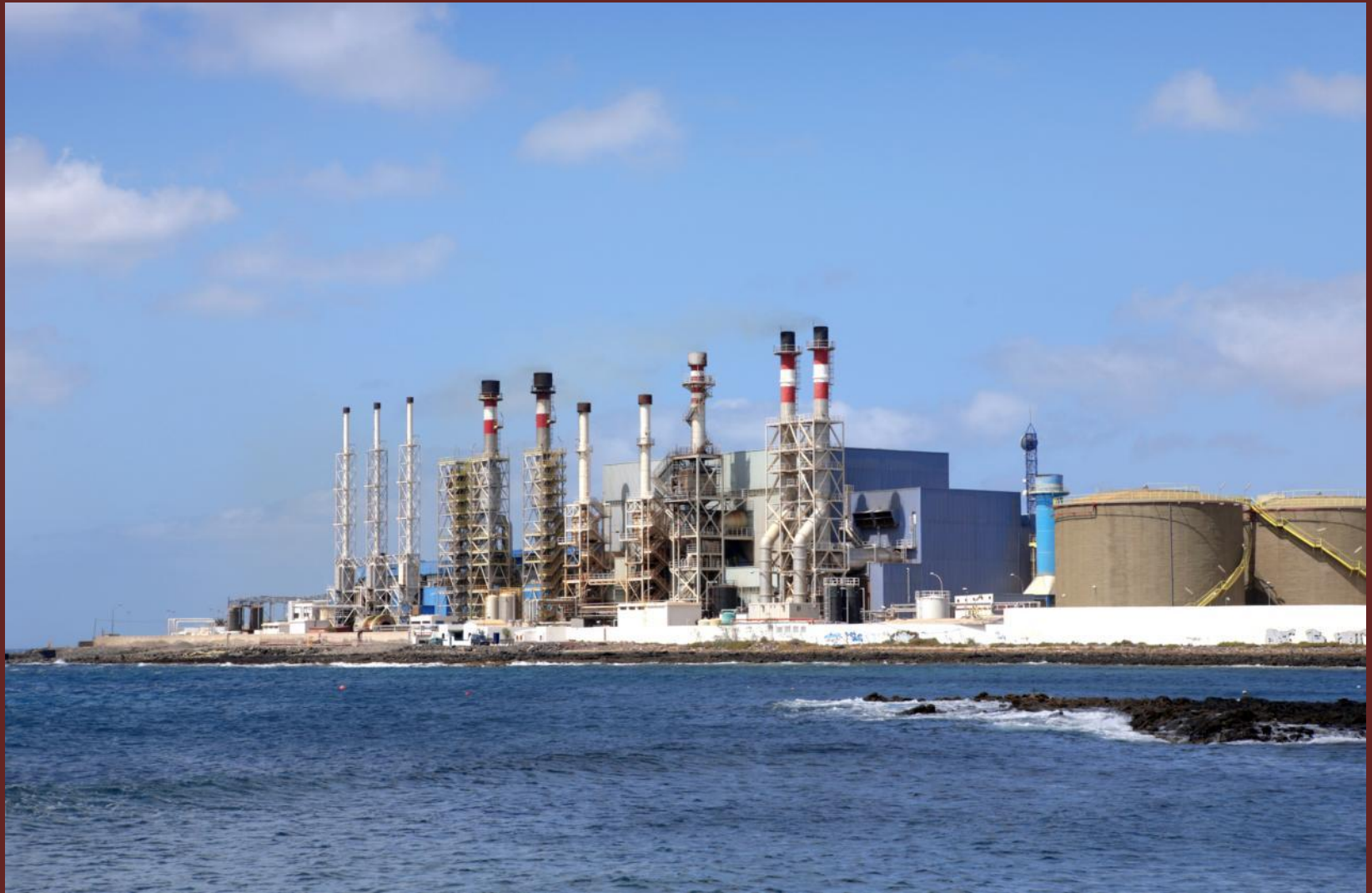
Завод по опреснению морской воды на острове Лансароте (Канарские острова, Испания)
