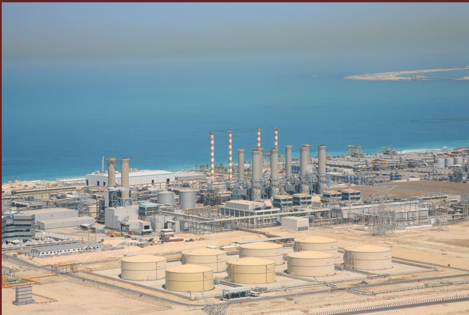
Завод по опреснению морской воды в Дубае (ОАЭ)
