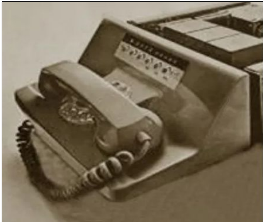
Bell Datarhone 103 – скорость передачи 300 бит/с
