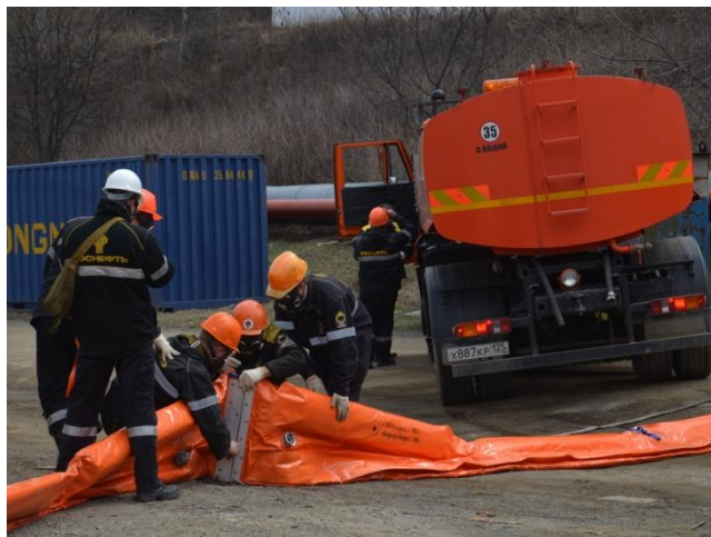
Установка бонового заграждения
