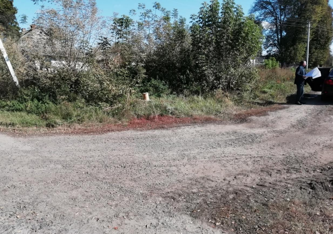
Строительство участка автодороги в с.Фатеевка
