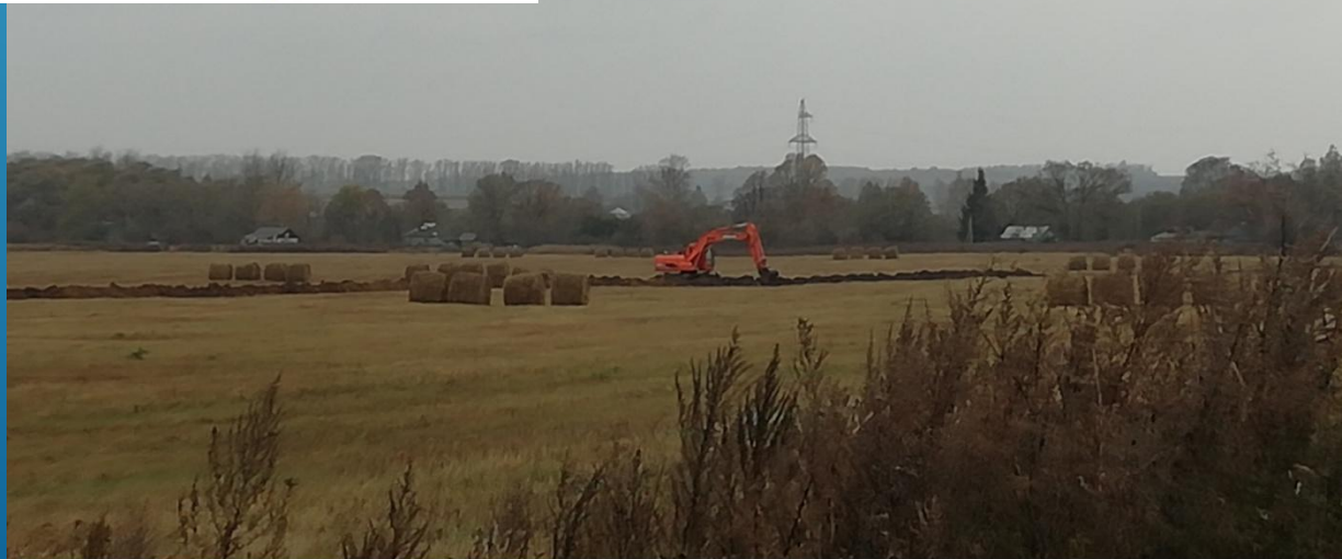
Продолжение строительства водопровода в с.Пальцево
