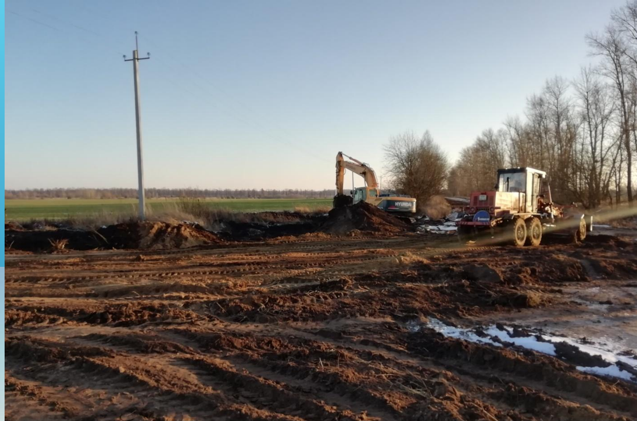
Начало строительства автодороги д.Новая Першина-д.Сухой Ровец
