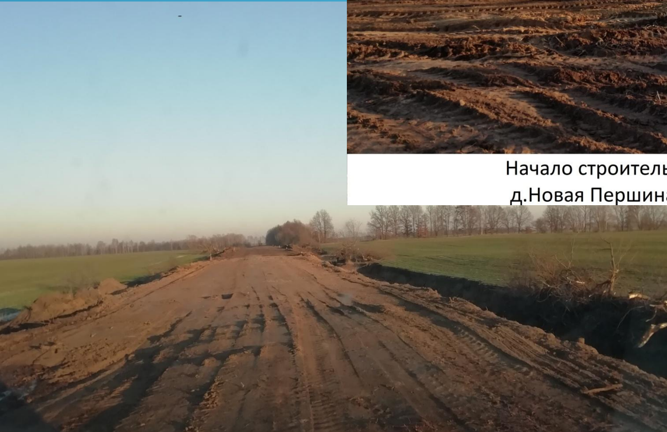
Строительство автодороги д.Новая Першина-д.Сухой Ровец
