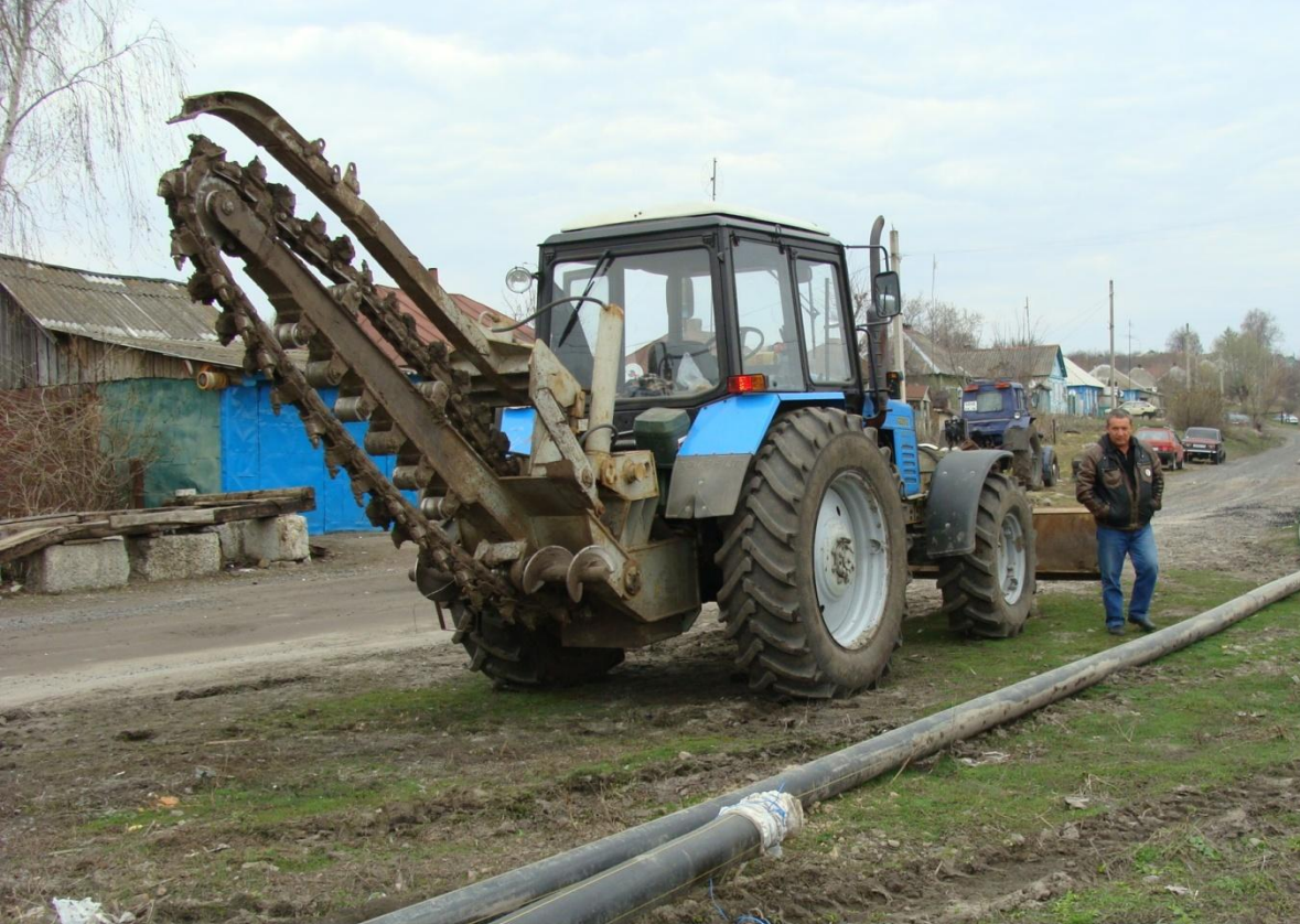
Строительство газопроводных сетей в с.Погодино
