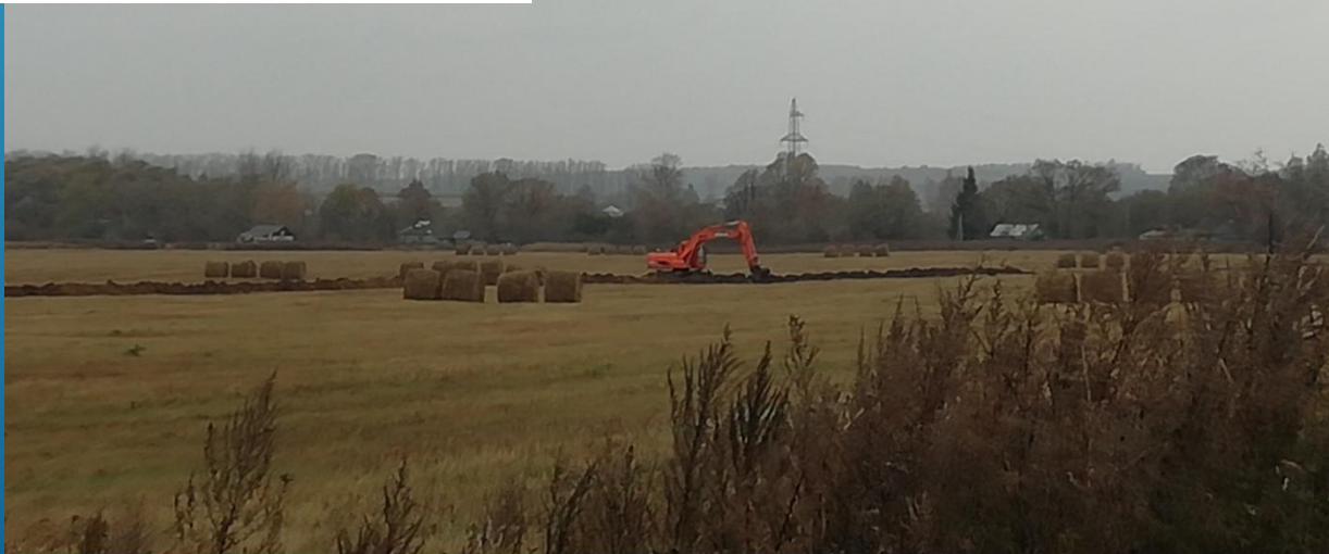
Продолжение строительства водопровода в с.Пальцево
