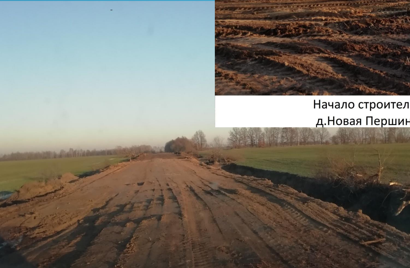
Строительство автодороги д.Новая Першина-д.Сухой Ровец
